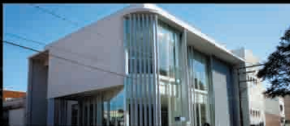
Agência CAIXA Econômica Federal - São Carlos / SP
